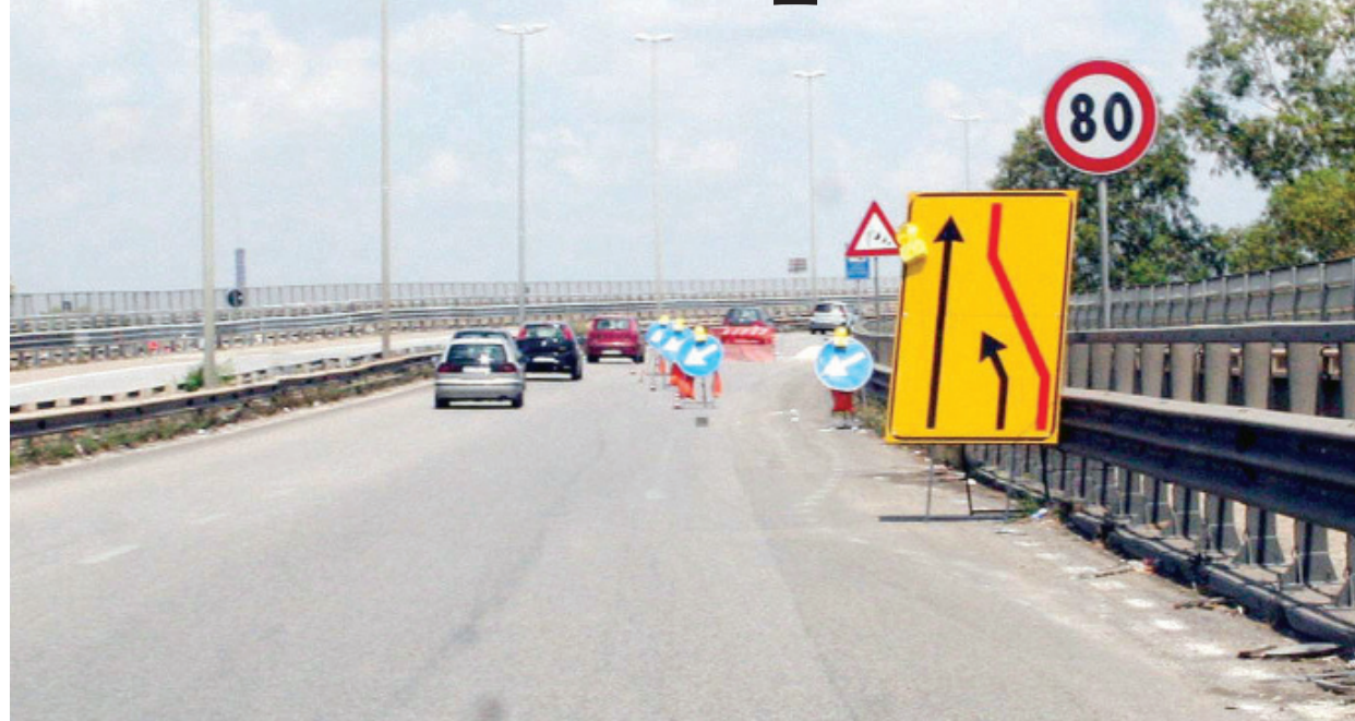
Nella foto d'archivio gli ultimi lavori sul Ponte Punta Penna (Studio Renato Ingenito)
